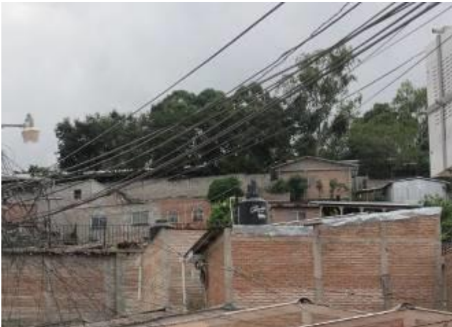
写真②事業対象地域の近景:外壁が塗装されていない簡素なレンガ造りの家が建ち並ぶ
