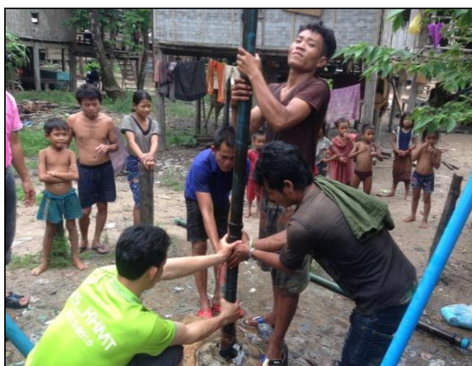
（ア-⑤）深井戸修理研修（1）
