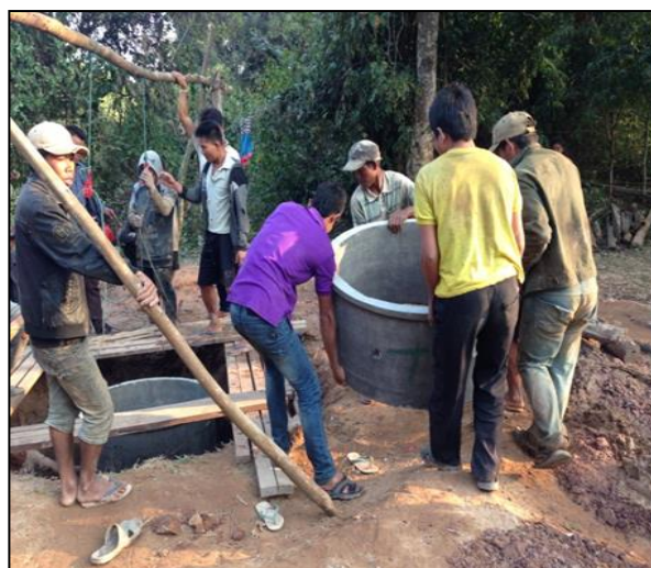
（ア-⑤）深井戸修理研修（2）
