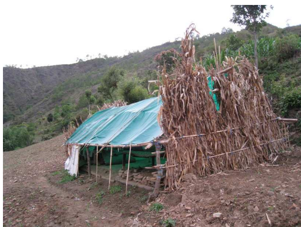
住民により建設された仮設住宅①
