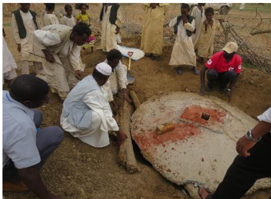
ウエスト村にて、住民の手で住戸用トイレが建設された
