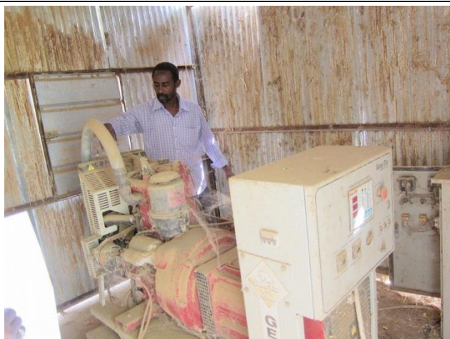
稼働せず放置されているアグドゥブ村の給水用エンジン
