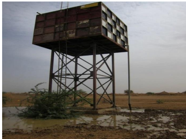
配管に漏水がみられるシンカットキナーブ・ウエスト村の給水タンク
