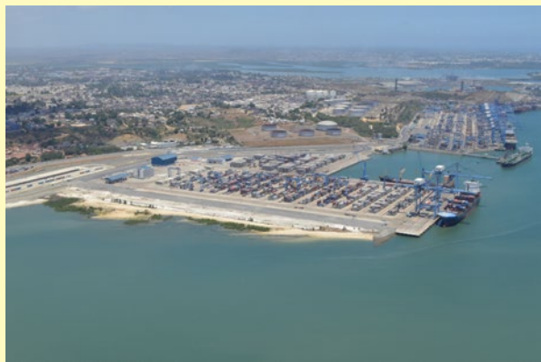
円借款の支援を通じて建設されたケニアのモンバサ港の新コンテナターミナル（写真：東洋建設）
