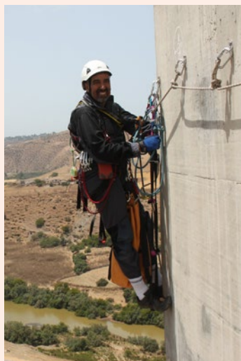
モロッコの高速度路の橋梁でニンジャテックを使って点検をする現地の技術者(写真:株式会社特殊高所技術)
