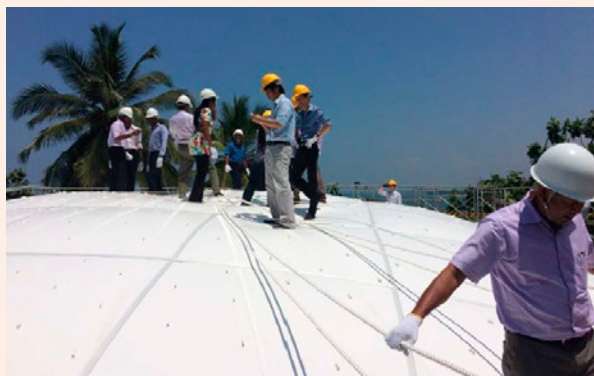
PCタンク上方のエアードームの据え付けを確認する日本及びスリランカの技術者たち（写真：安部日鋼工業）
