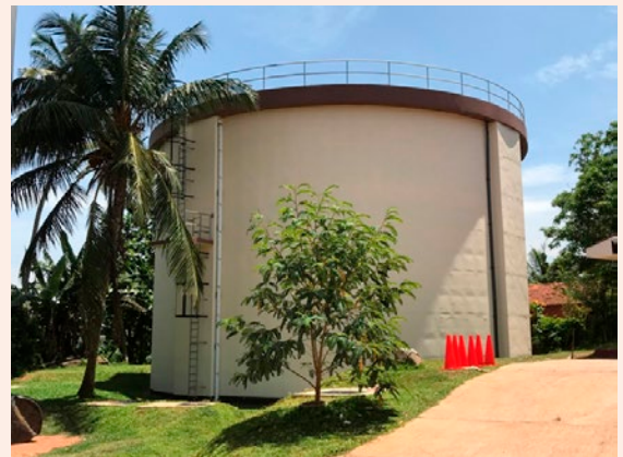
安部日鋼工業がスリランカ南西部のバールワラ市に建設したPCタンク（写真：安部日鋼工業）
