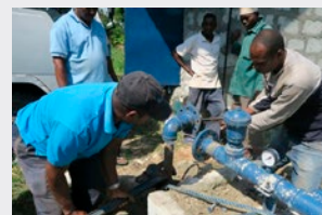
ザンジバル水公社による井戸の修理作業（写真：JICA）
