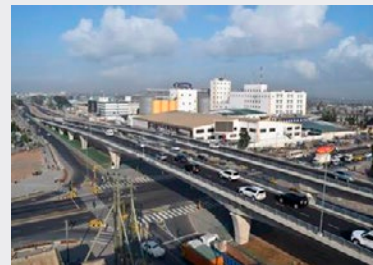
完成したタザラ交差点（写真提供：オリエンタルコンサルタンツグローバル）
