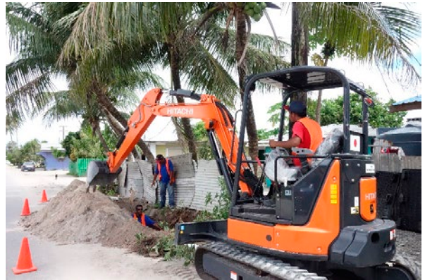
マーシャル諸島の首都マジュロ環礁の道路脇にて、草の根・人間の安全保障無償資金協力により整備された小型エクスカベーターを用いて、水道管設置のために土を掘り起こしている様子。（写真：関千鶴）
