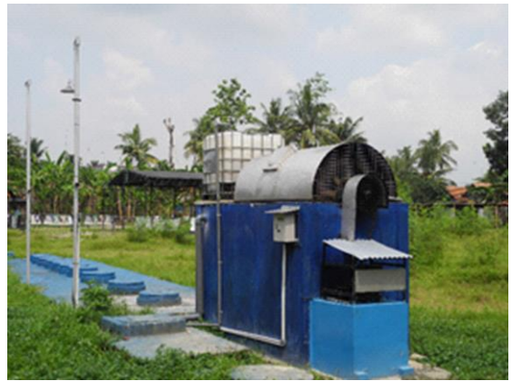
コミュニティ排水処理モデルシステム (中部ジャワ州・ケブメン県)
