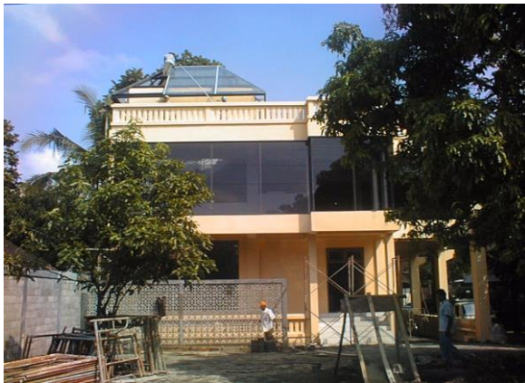
排水処理適正技術センター (ジョクジャカルタ、事業の拠点)
