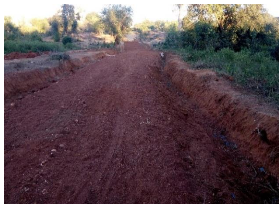
施工後の道路
