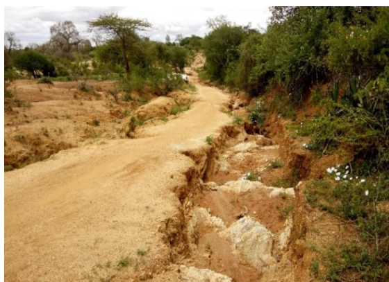
施工前の道路
