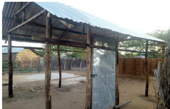
仮設住宅の骨組みができた状態
