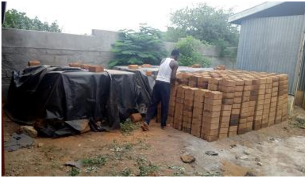
乾燥させたブロックを積み上げる作業
