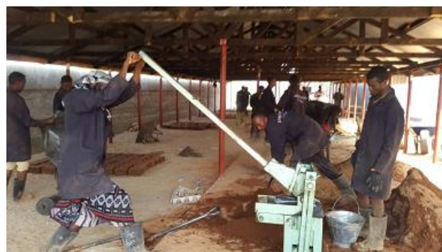
ブロック製造機を操作する訓練生
