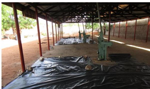
ISSB ブロック製造技術研修施設
