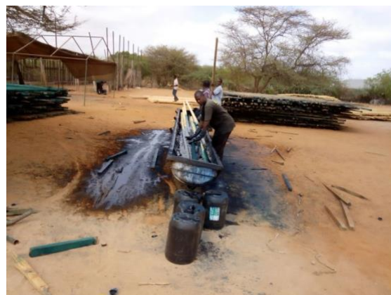
屋根に使用される角材に防腐剤を塗布する作業
