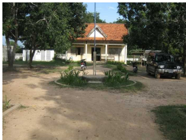
開始②: 敷地舗装する前の対象校の国旗掲揚台周 辺の様子。(クサイ・カンダール郡チェイ・モンコル小 学校、2016 年 11 月 23 日)
