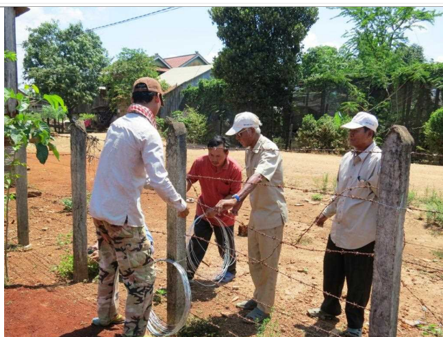
保健ボランティア会議で話し合っ、保健センター周りのフェンスを自分たちで修理している。自主性ができた。
