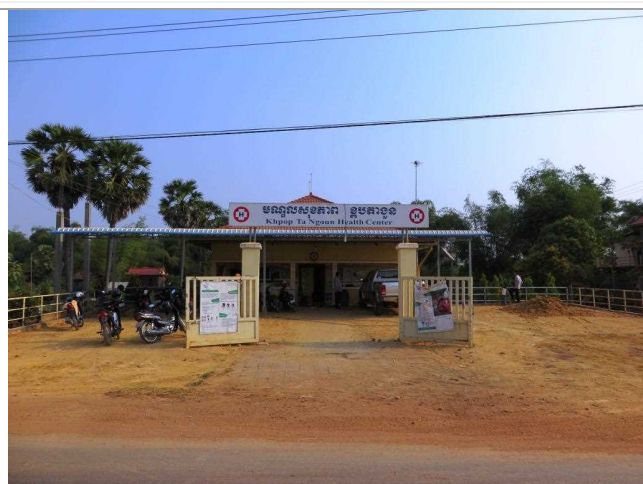
土手埋め立て工事完成後の保健センター正面の写真。
