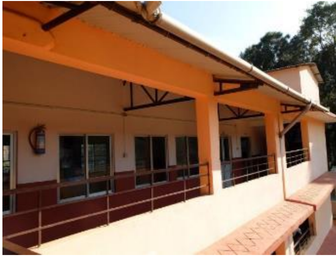
増築した 4 階部分
