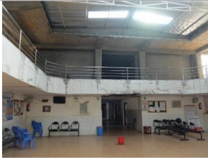
行政予算で 2 階部分の建設が進められている
