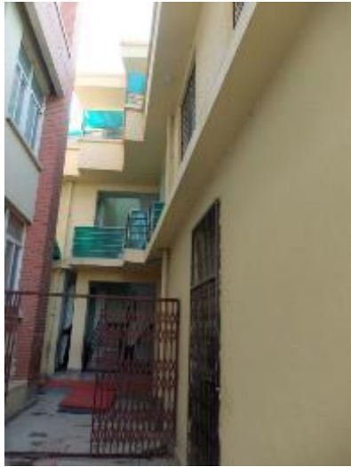
GGP で建設された 3 階建ての宿舎
