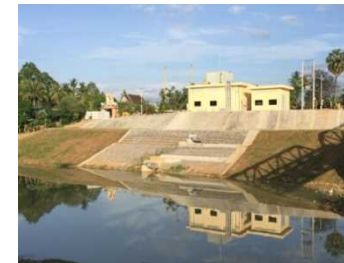
バットンバン取水施設
