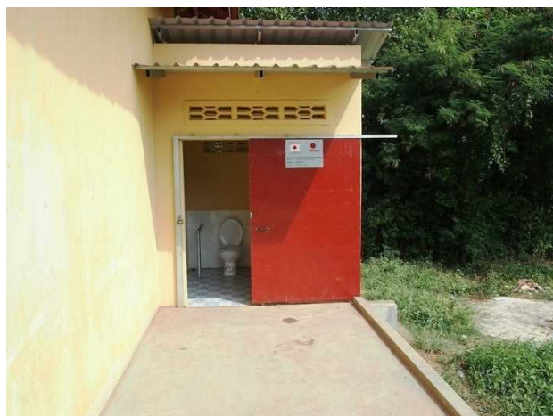
完了①: 完成したバリアフリー仕様のトイレ。(クサイ・カンダール郡ポクルツサイ・クラオム小学校、2017 年 1 月 11 日)
