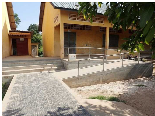
完了③: 舗装した敷地から校舎につながるスロープと、新設したトイレ(左奥)。(クサイ・カンダール郡プラエク・ルオン小学校、2017 年 4 月 22 日)
