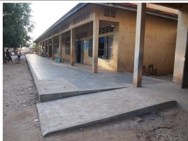
完了④: 校舎前の舗装と設置したスロープ。(クサイ・カンダール郡スバイ・チュルム小学校、2016 年 11 月 29 日)
