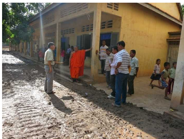
開始④: 工事業者と校長、僧侶、当会職員などの関係者が校舎前の舗装について協議する様子。(クサイ・カンダール郡スパイ・チュルム小学校、2015年9月4日)
