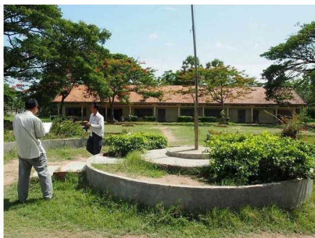
開始②: 敷地の舗装箇所について確認する工事業者。(クサイ・カンダール郡プラエク・オンパル小学校、2015年7月10日)
