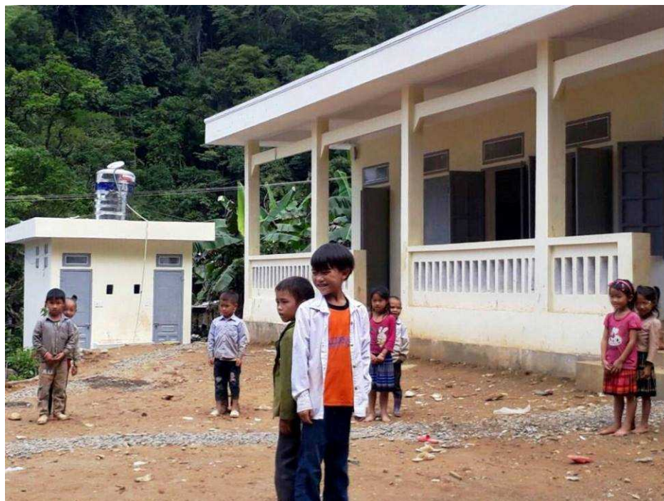
3教室を建設したスオイスートン小学校(ライチャウ省シンホー郡)。以前の教室は虫食いと雨漏りで木が腐りかけ、壁の一部が剥がれていた。頑丈な新校舎には今年度、1～3年生の児童45人が通う。
