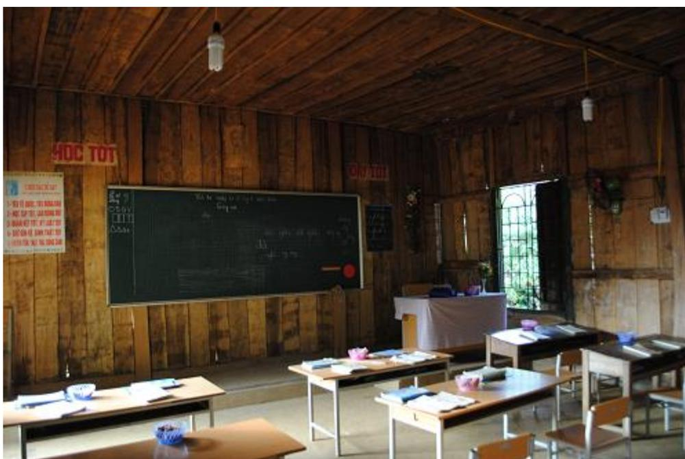
同じく第1期の建設対象校、スオーストン小学校の教室内(ライチャウ省)。虫食いと雨漏りで木が腐りかけ、壁の一部が剥がれている。
