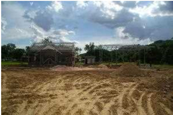
建設中の CLC#5
