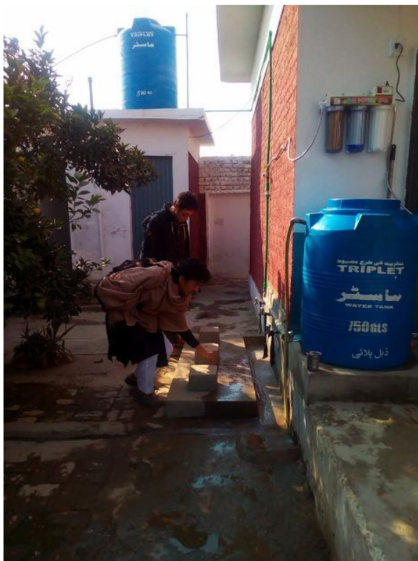
工事が完了した学校で、設置した井戸、給水タンク、浄水器および手洗い場の状態を確認する駐在員の山本祐一郎（手前）と本部事業担当の藤本矩大（奥）。（パキスタン公立女子小学校 GGPS Sari、2016年12月5日撮影）
