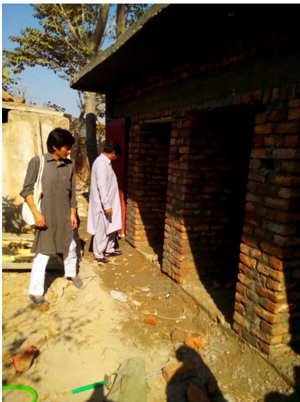
アフガニスタン難民居住地域内女子小学校におけるトイレ建設の様子。写真左は、工事のモニタリングを行う駐在員の山本祐一郎。（アフガニスタン難民居住地域内女子小学校 PSG 267、2016年11月8日撮影）
