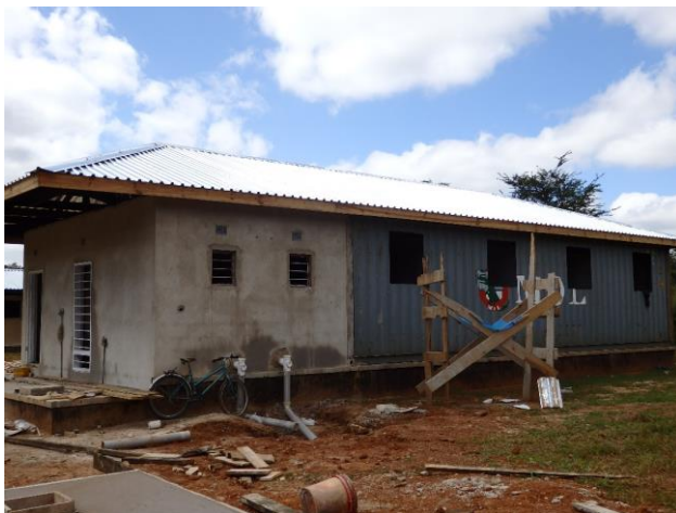
マタニティハウス（出産待機ハウス）建設 （ムポングウェ郡カルウェオ地区）
