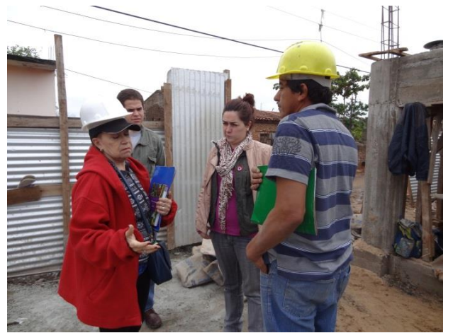
建設状況について話し合いながら工事を進めた
