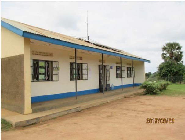
1. TPO ユンベ事務所概観
