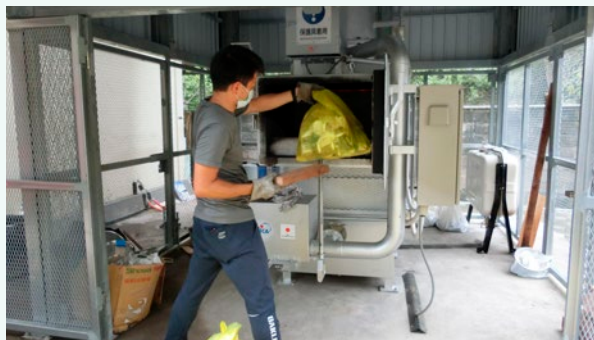
小型焼却炉チリメーサーにゴミを入れているところ。 (写真提供：(株)トマス技術研究所)
