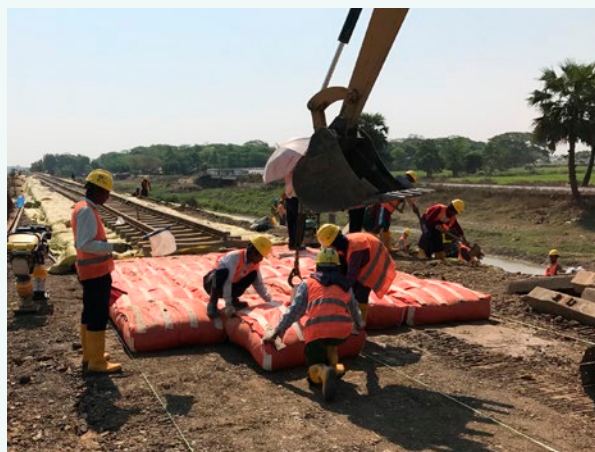
ミャンマーの鉄道整備工事でD・BOXを敷設している様子。 (写真提供：メトリー技術研究所(株))
