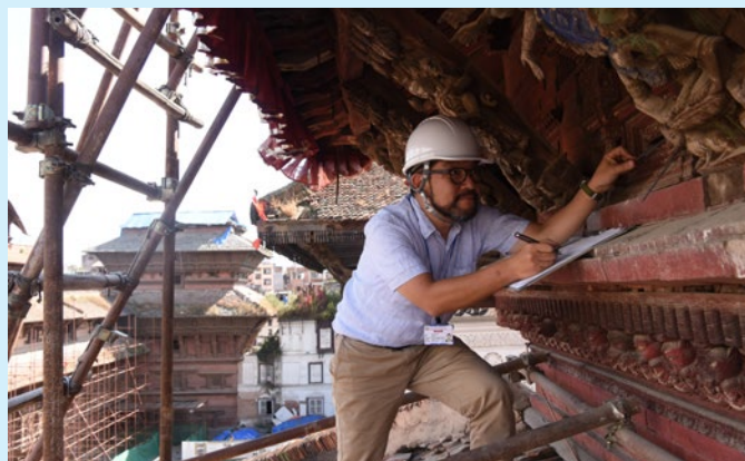
アガンチェン寺の屋根上で実測調査を行う多井忠嗣さん。（写真提供：多井忠嗣）
