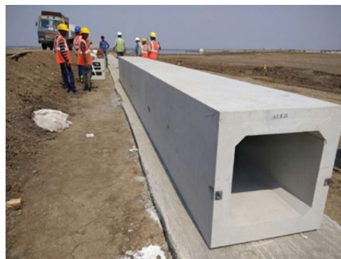
排水用プレキャスト製品。品質は日本国内と同等であり、インドでは最高品質と評価されている。
