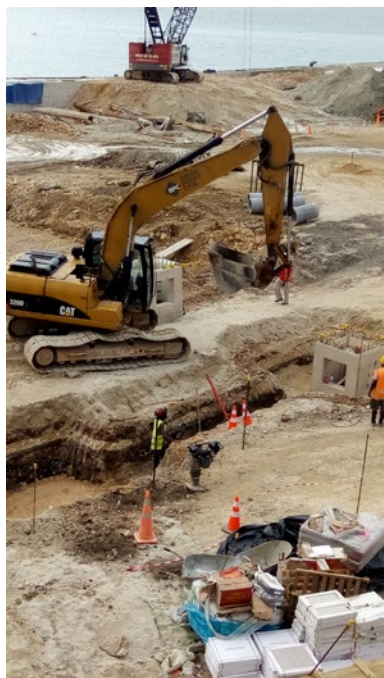
バヌアツのポートビラ港パタシ国際多目的埠頭整備計画プロジェクトサイト。排水パイプの設置のための掘削工事の様。 (写真：武田晶／(株)エコー)
