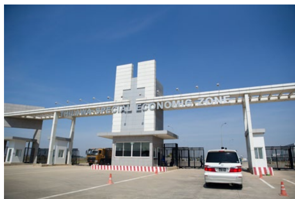
ミャンマーの商業都市ヤンゴン近郊で開発が進むティラワ経済特別区の入口。（写真：久野真一/JICA）
