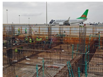
国際線到着ターミナルの基礎躯体工事現場の様子。（写真：Gyros株式会社）
