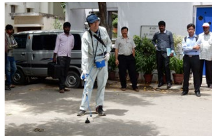
漏水音と確認されたLED点滅箇所に対し、漏水探知器により、漏水確認および漏水位置の特定を行う技術講習の様子。
