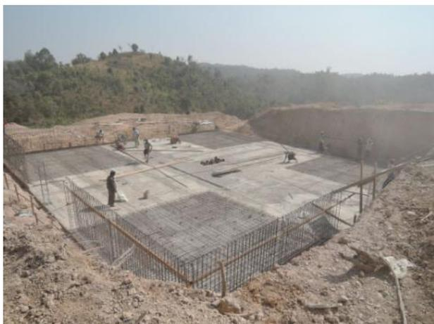
メイン水タンク建設工事（骨組み）
