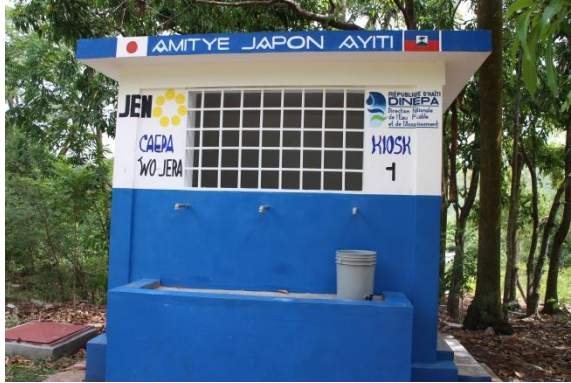
完成したキオスク型給水施設 1 号棟
