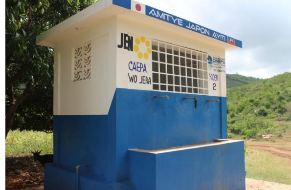
完成したキオスク型給水施設 2 号棟
