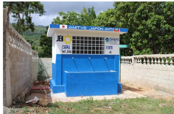
完成したキオスク型給水施設 4 号棟
