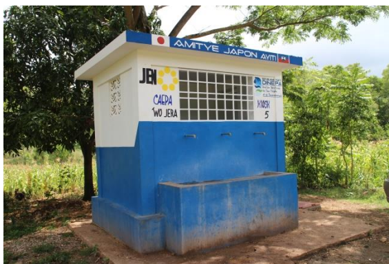
完成したキオスク型給水施設 5 号棟
