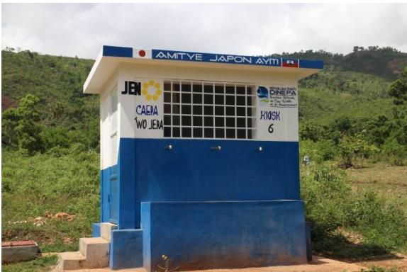
完成したキオスク型給水施設 6 号棟
