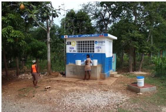
完成したキオスク型給水施設 3 号棟
