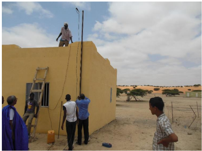
砂漠の村落無線局のアンテナ交換作業。
