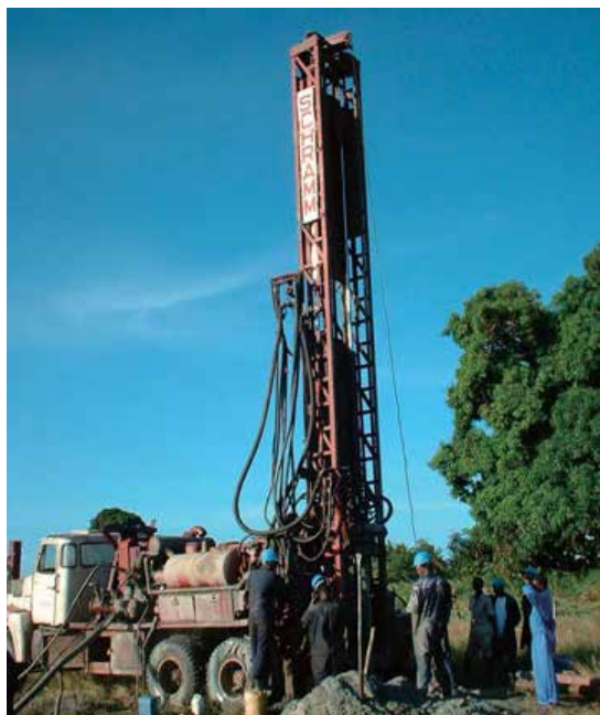
首都圏周辺地域給水計画（第2期：試験井戸掘削の様子）
