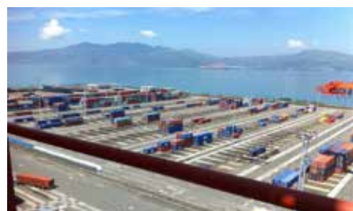
フィリピン「スービック港開発事業」（セクター課題の深掘）から、コンテナターミナルの様子
