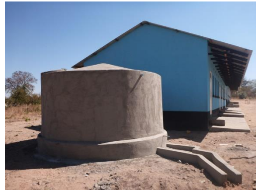
ガンガンが中学校での貯水タンク（30,000L）建設の様子
