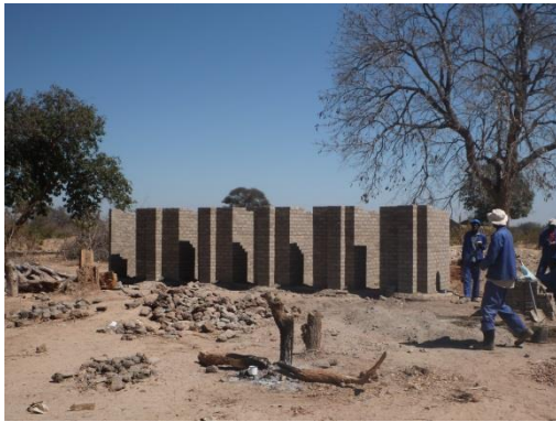
ネバナ小学校でのトイレ建設の様子
