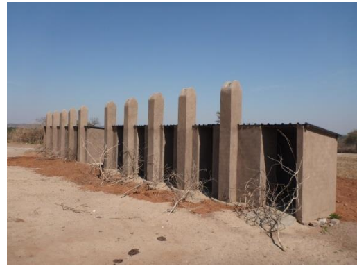
チオザ中学校でのトイレ建設の様子
