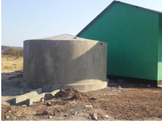
チオザ中学校での貯水タンク（30,000L）建設の様子
