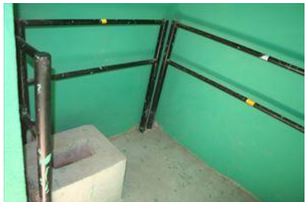
設置した障害者用の個室
