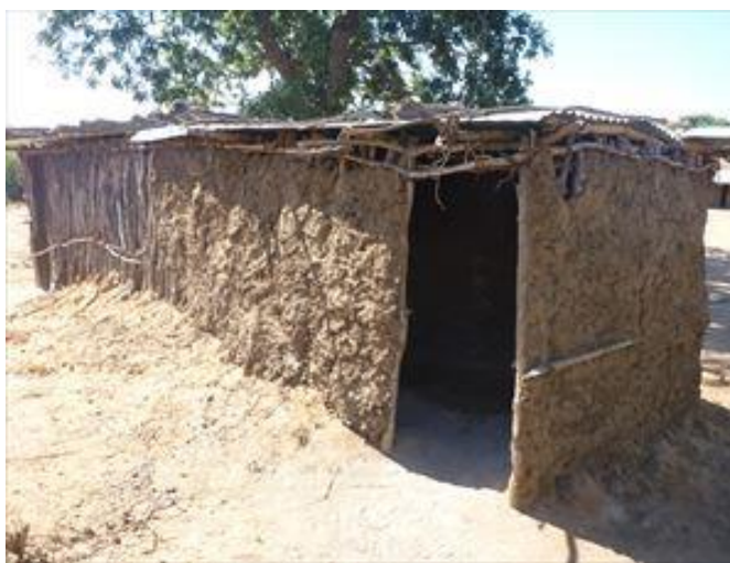
土でできたグラ小学校のトイレ
