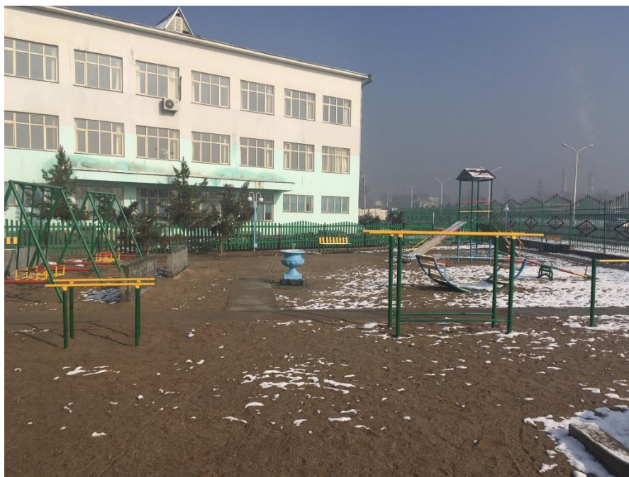
【写真 2】学校 No. 72 にて修繕が完了した体育用具と遊具スペース。(2017 年 1 月 13 日)
