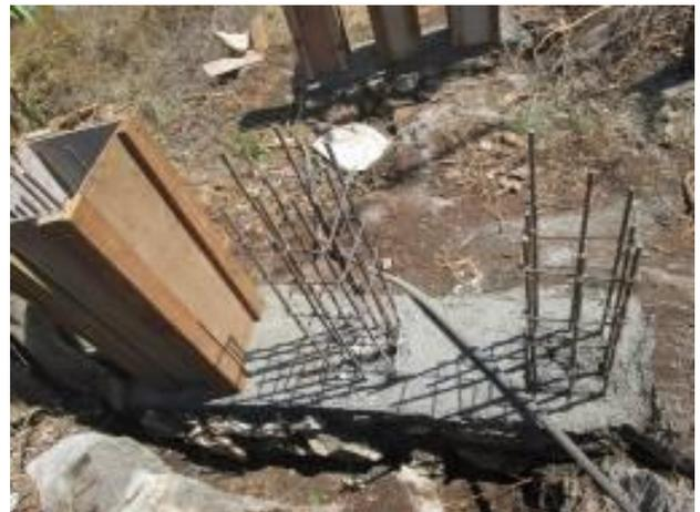
左…ライン 2(南)用配水パイプ土台、中…ライン 2(南)用揚水パイプ土台、右…ライン 1(北)用揚水パイプ土台
