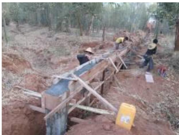
川の上に水パイプを配管するための橋を作成中(インデイン村)
