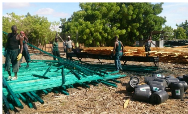
角材の防腐処理（手前が処理済み、奥が処理前）
