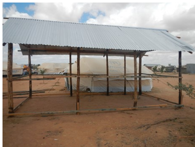
屋根取り付け後
