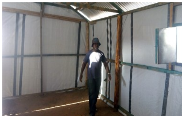
完成した仮設住宅内観
