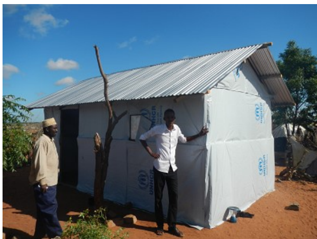
完成した仮設住宅外観
