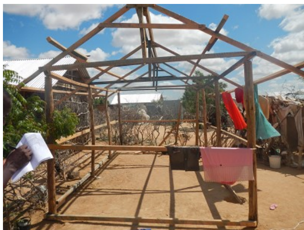
仮設住宅の骨組み
