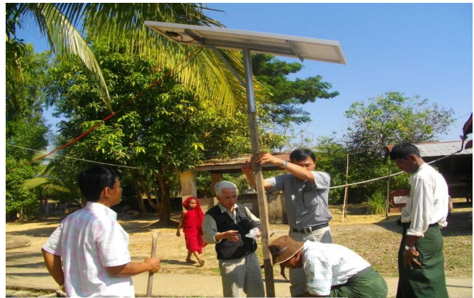
ソーラーパネルの組み立て作業
