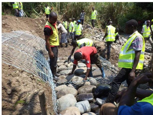
河道掘削時に集めた石を鉄線の籠に敷き詰めていく。2段の石籠を積み重ねて護岸を行った（チャランガ村）
