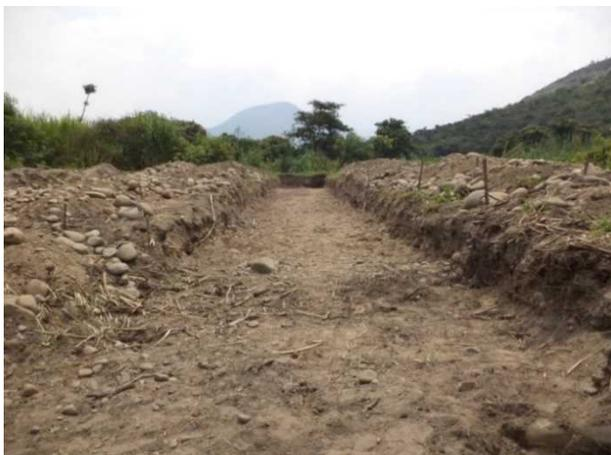
村の住民たちによる掘削作業の後。河道をなるべく直線的に修正し、今後蛇行するリスクを抑制する（チャランガ村）
