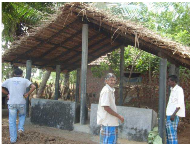
完成した牛舎⑪（キリベッティー組合）
