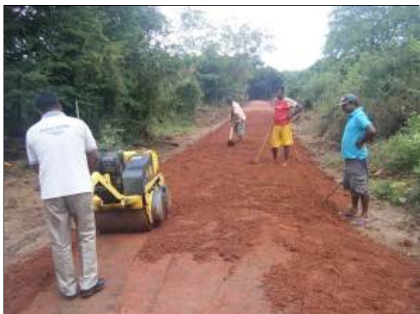
貯水池へのアクセス道路整備：ゴマランカダウ エラ郡 クダウエワ貯水池（2014年2月24日）
