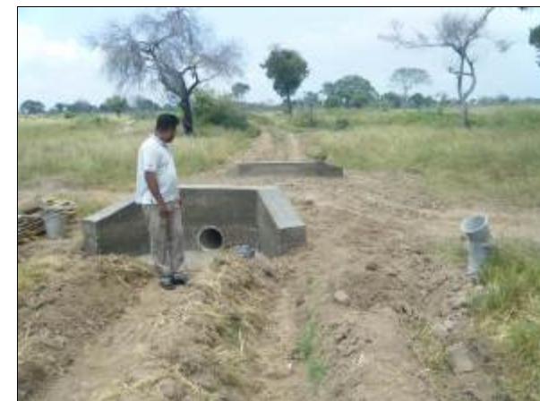
道路下を交差する用水管の設置：クッチャベリー 郡 プリヤンクラム貯水池（2014年2月24日）
