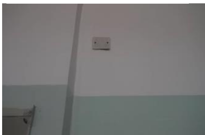
↑ 屋内 むき出しだった配線を中心に埋め込んだ
