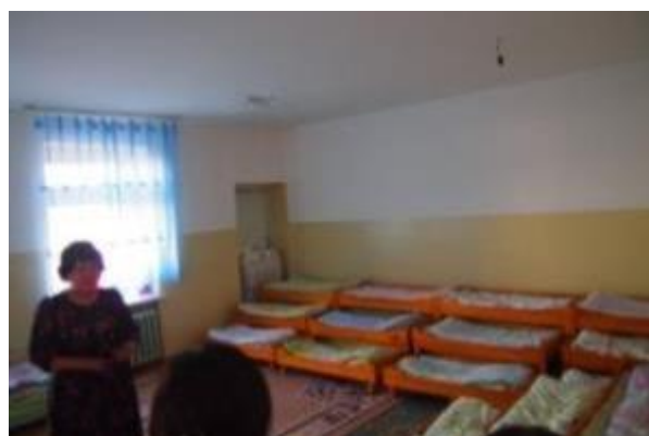
↑ 改修した教室
