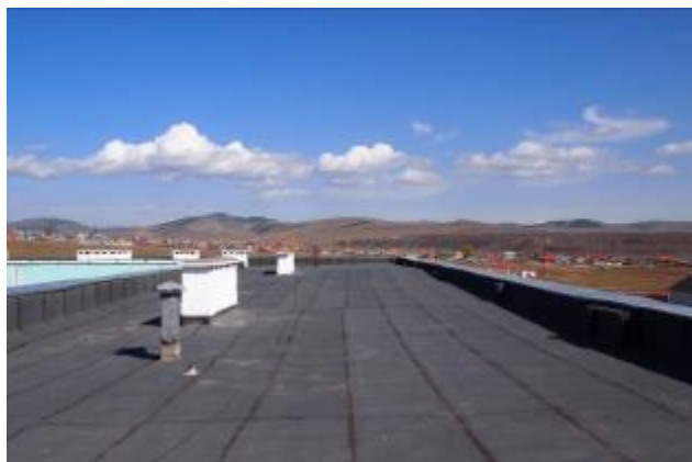
↑ 屋上、修繕した屋根
