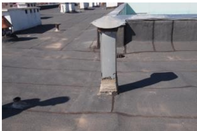
↑ 屋上、修繕した換気口
