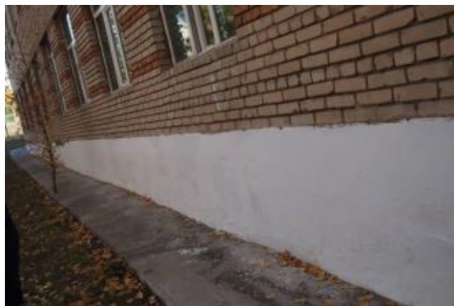
↑ 外壁。雨が降っても浸透しないよう、コンクリートで固めた。
