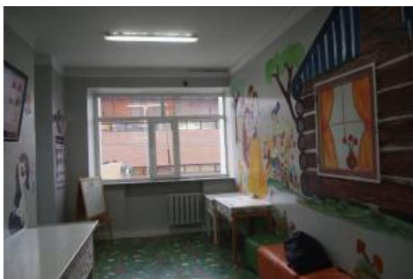
↑ 改修した窓、窓枠
