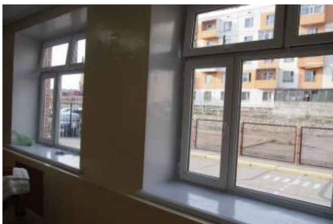
↑ 改修した窓、窓枠
