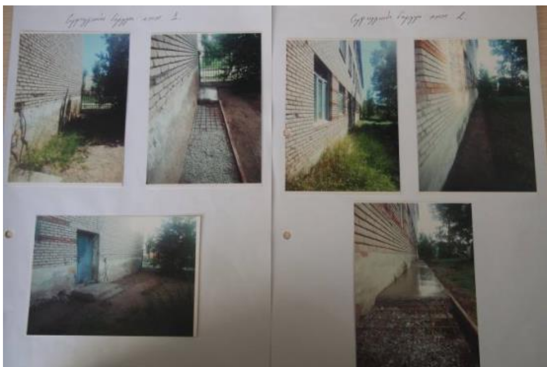
↑ エンジニアによる工事前、工事後の写真
