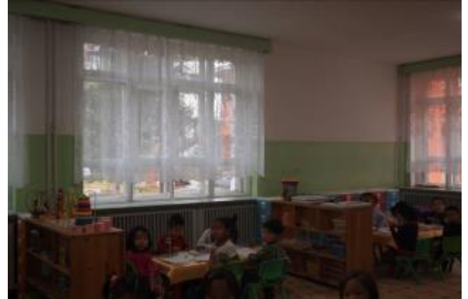
↑ 改修した教室の窓、窓枠
