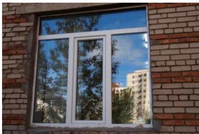
↑ 修繕した窓、窓枠
