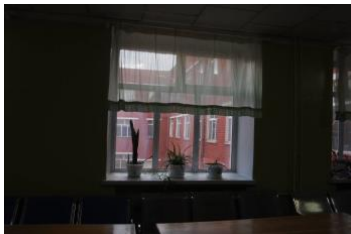
↑ 修繕した窓。かつては木製窓枠の老朽化でゆがみが生じ、隙間があり外気が入り込んで冬季は寒さの原因になっていたが、現在はしっかりとしたサッシ窓がとりつけられ、外気が遮断されていた。
