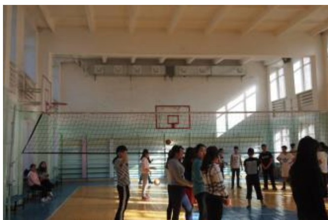
↑ 換気扇を設置した体育館
