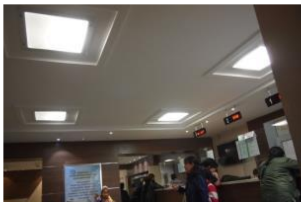
↑ 修繕を行った受付の天井
