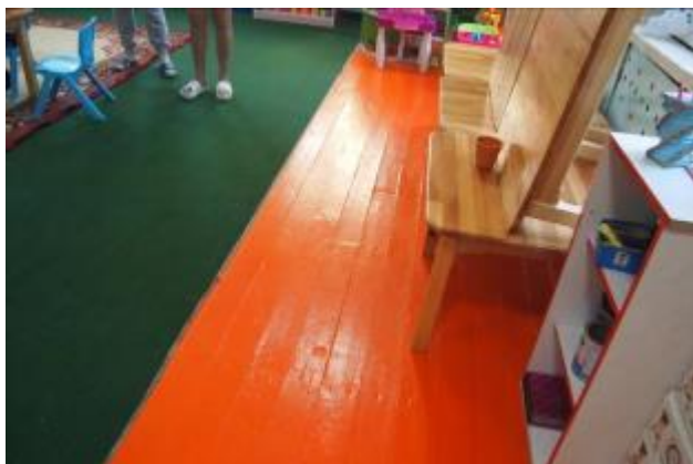
↑ 修繕した教室の床
