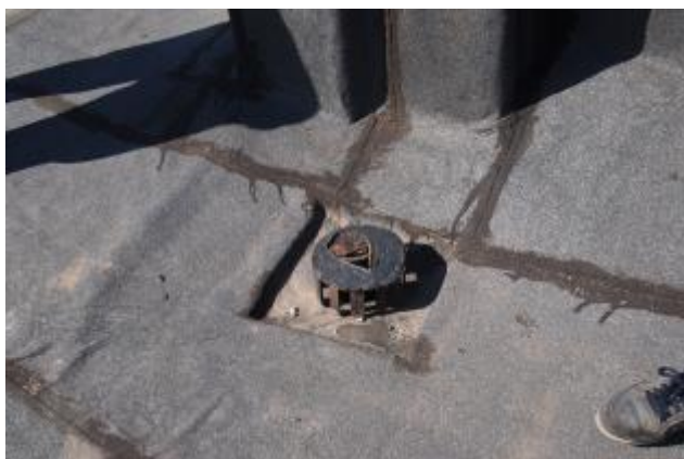
↑ 屋上、修繕した排水溝
