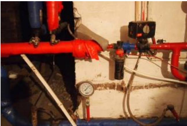
↑ 修繕したボイラー室の配管①
