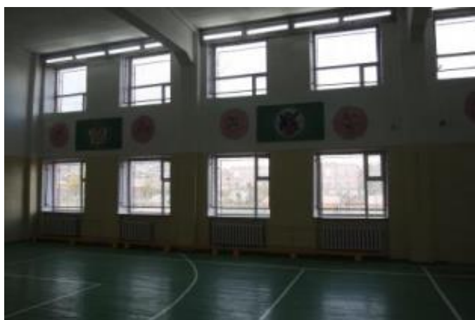
↑ 体育館(窓を修繕)
